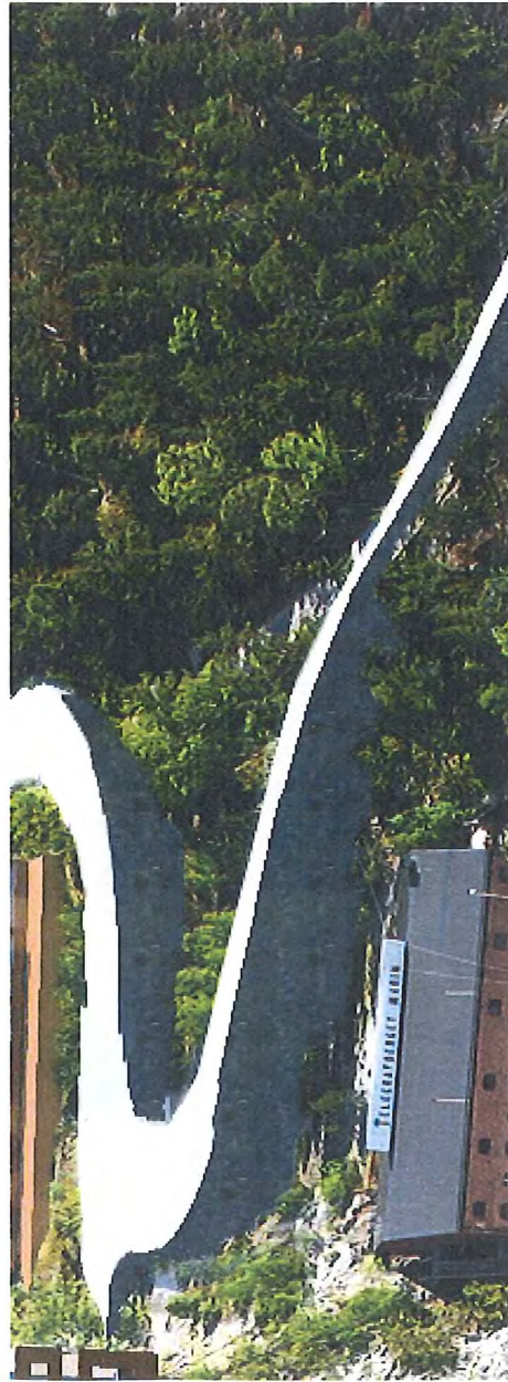
Stödmur klädd med vegetation
