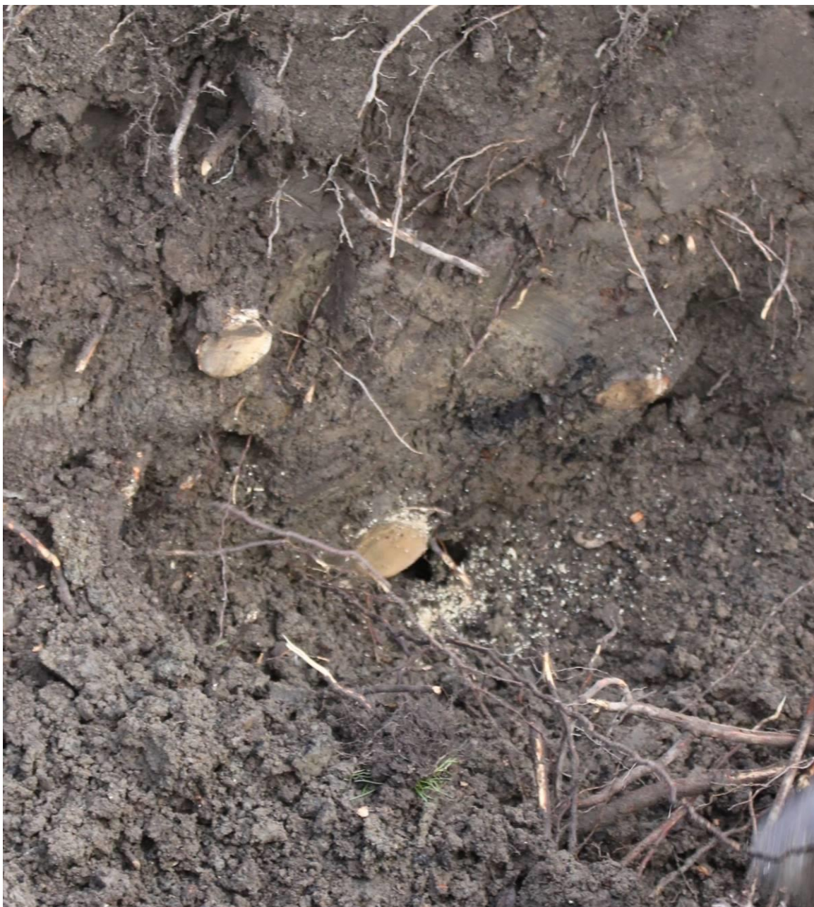
Bild 5. Korrekt beskurna rötter vid schakt.
