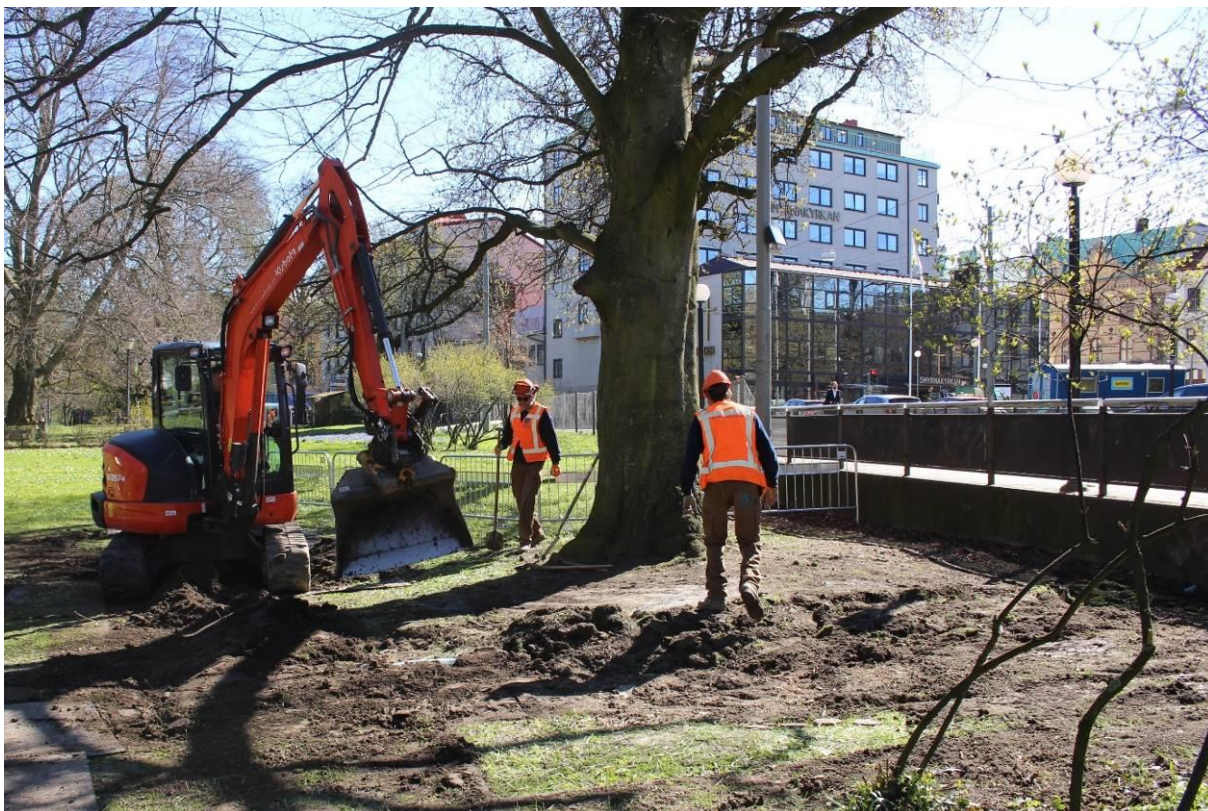
Bild 9. Avtagning av grässvål vid utförande av markvitalisering.
