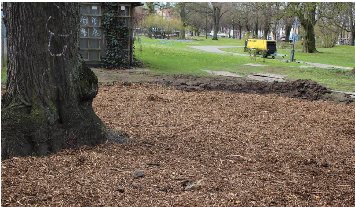
Bild 11. Färdigutlagt mulchlager vid markvitalisering.
