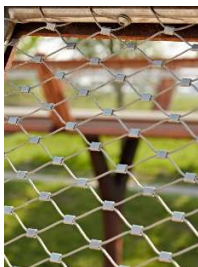
Räcke av stålvaier
