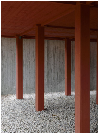
Smäckra träpelare och träram som stöd för balkonger
