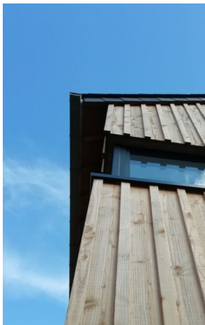
Takfot med bandplåts-täckning lika tak.
