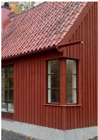
Takfot fortsatt likt befintlig som passerar förbi takkupa på övre plan. Rödmålad undersida.
