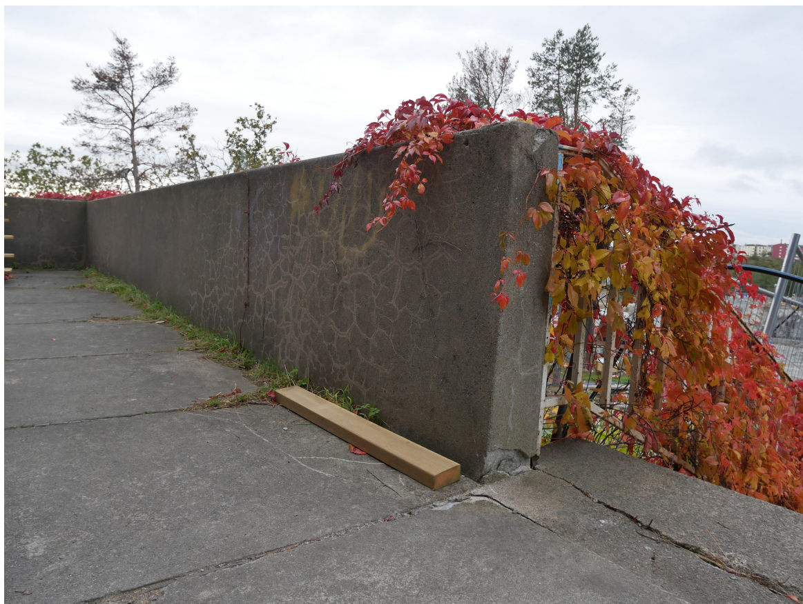
Terrass med putsad betongmur och betongplattor. Övre del betongtrappa med stålräcke. 2019.
