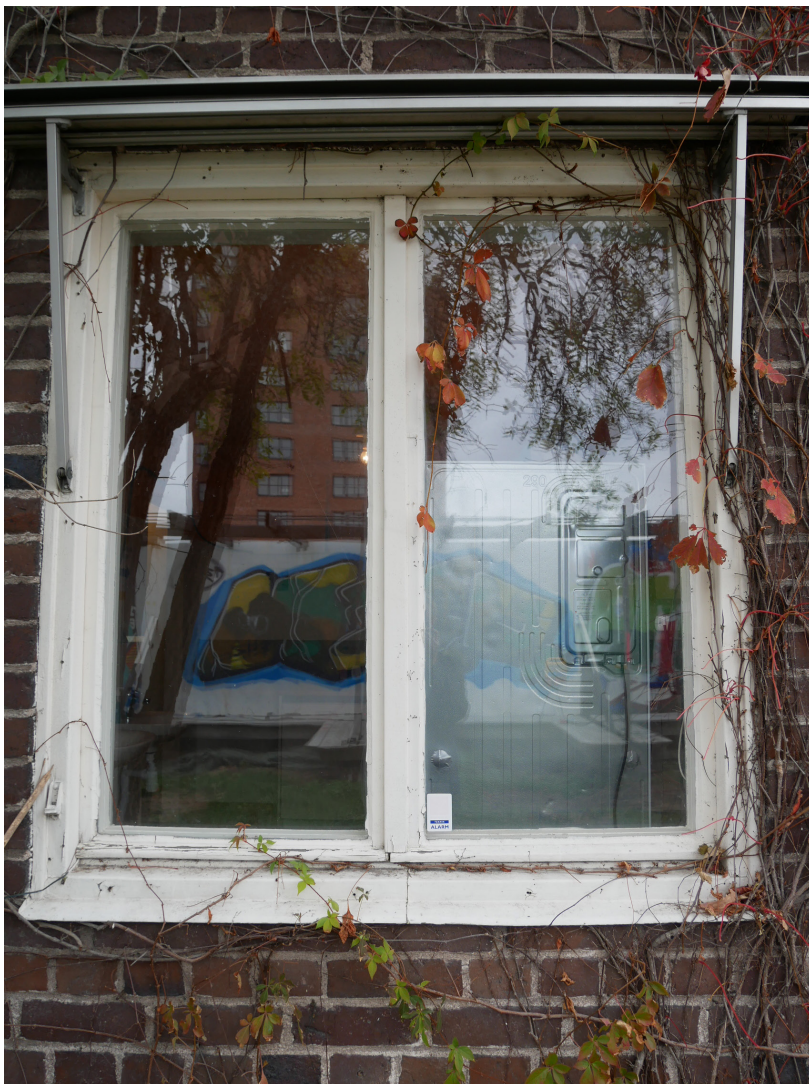
Fönster i bottenvåningen. 2019.
