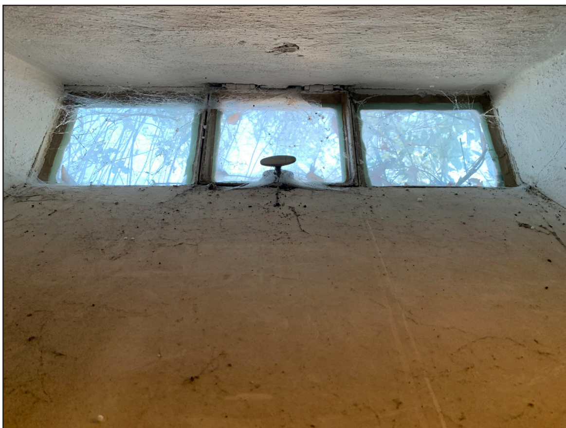
Källarfönster i metall. Sett inifrån. 2019.
