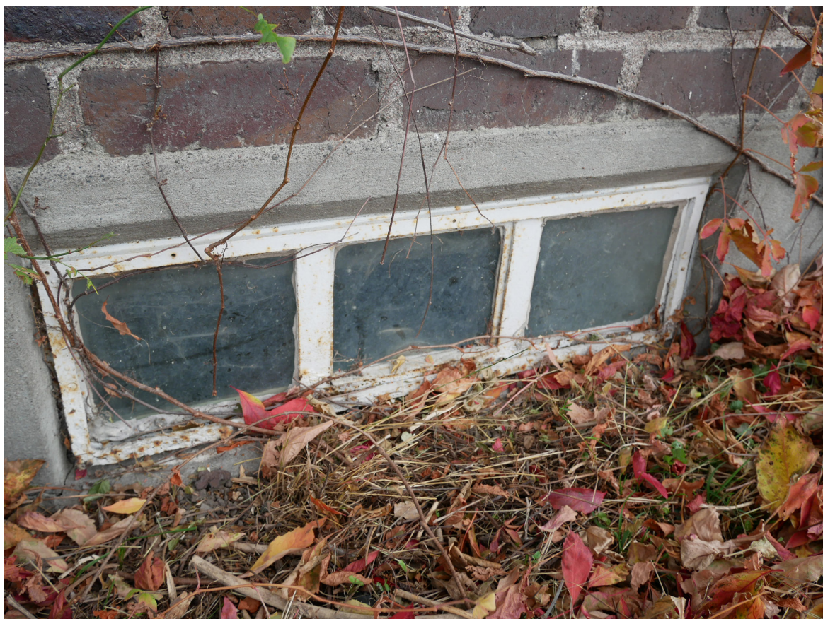
Källarfönster i metall. Sett utifrån. 2019.
