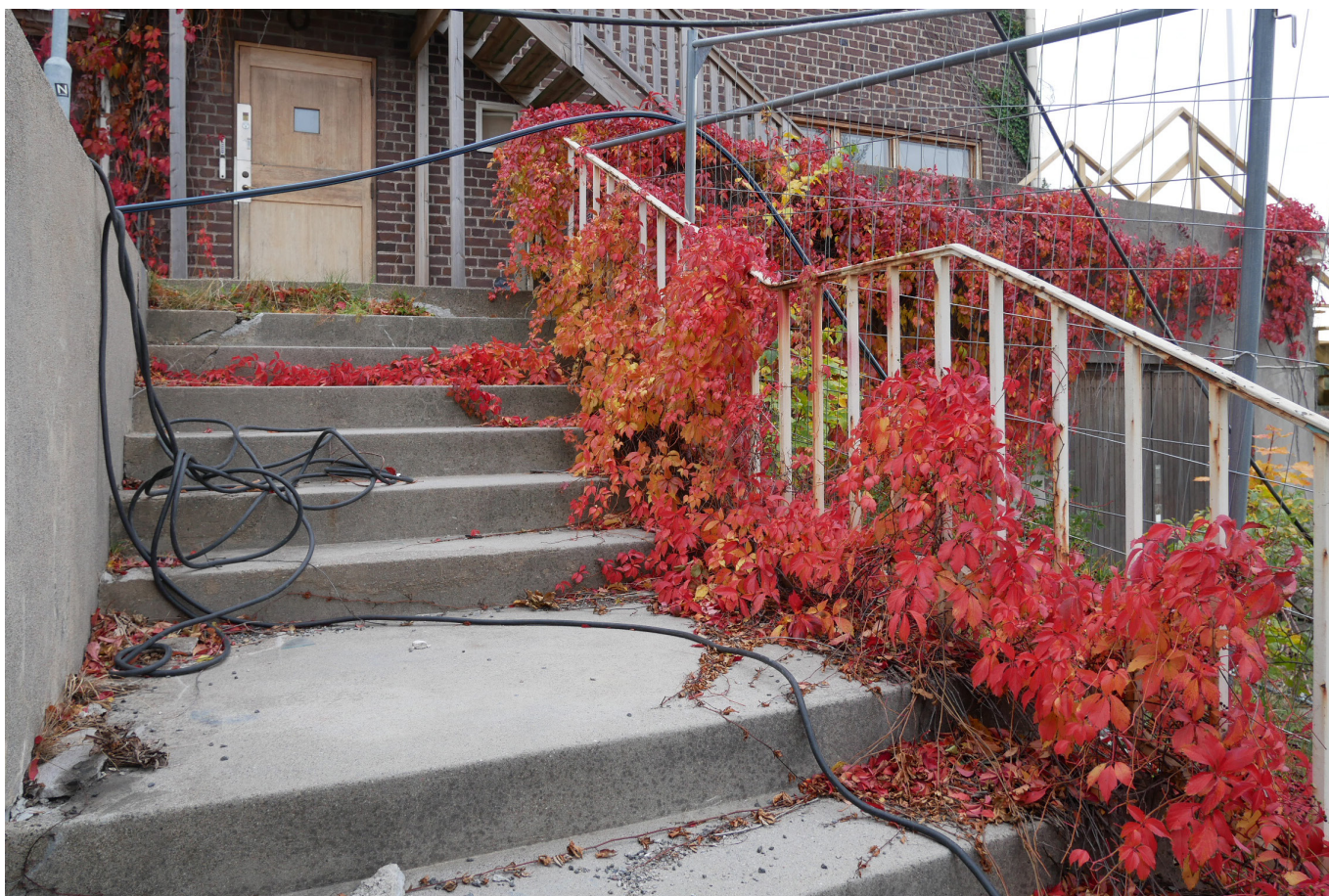
Trappa och terrassmurar i betong i trädgården vid huvudentrén. 2019.
