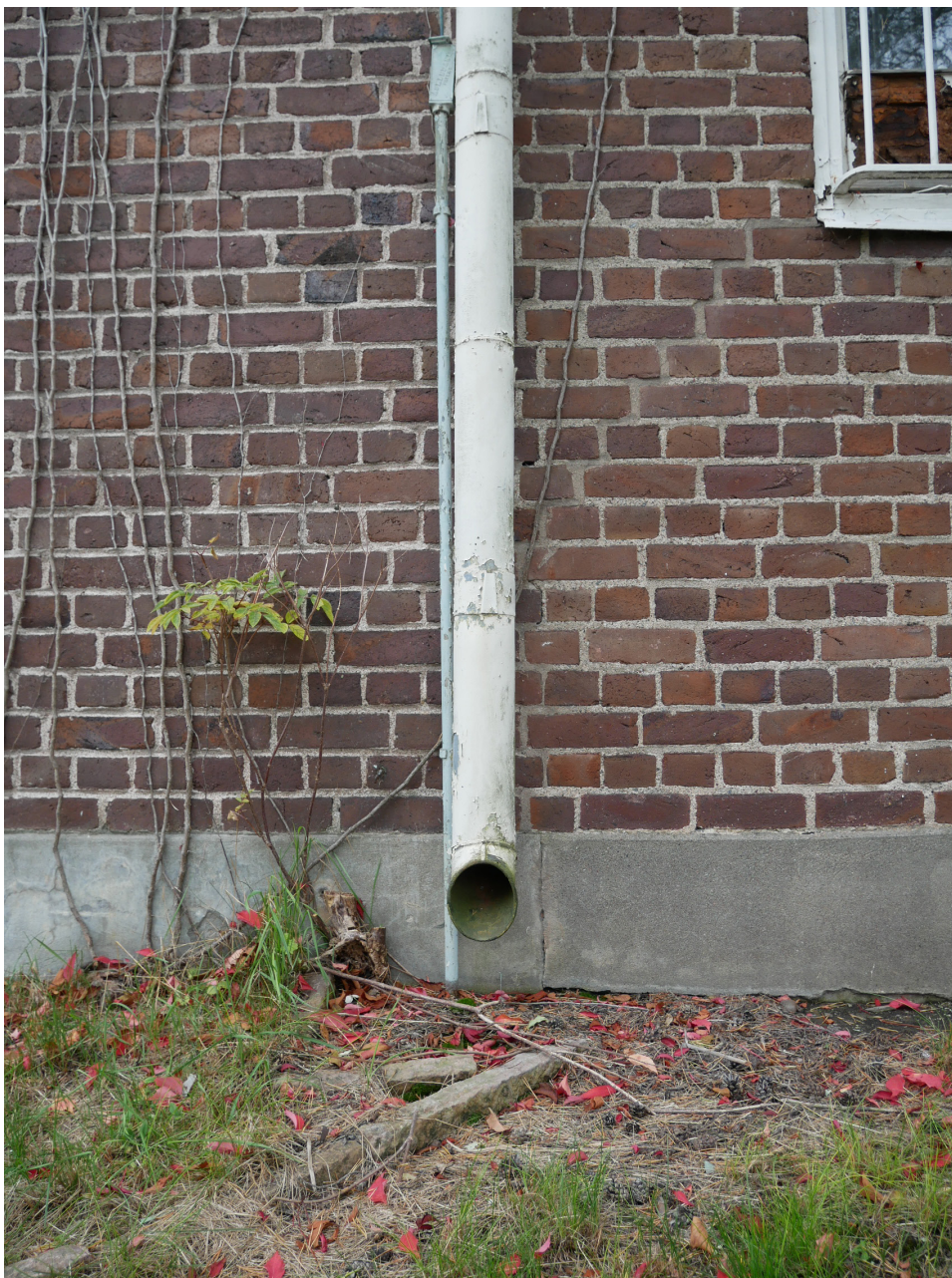
Stuprör vid trappustillbyggnad mot trädgården. 2019.
