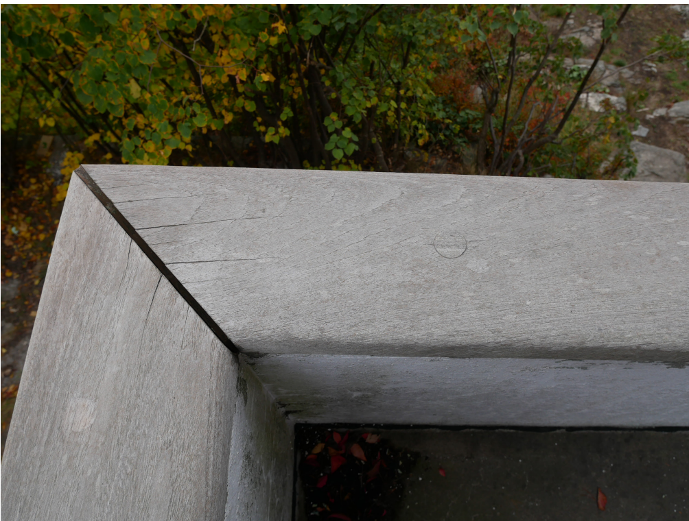
Räcke med överliggare av trä, balkong ovan burspråk. 2019.
