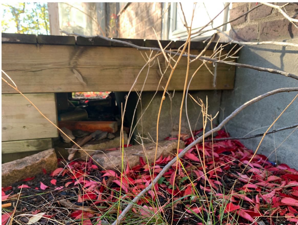
Betongavsats vid fönsterdörr mot trädgård. Senare tillkommen trätrappa rivs. 2020.
