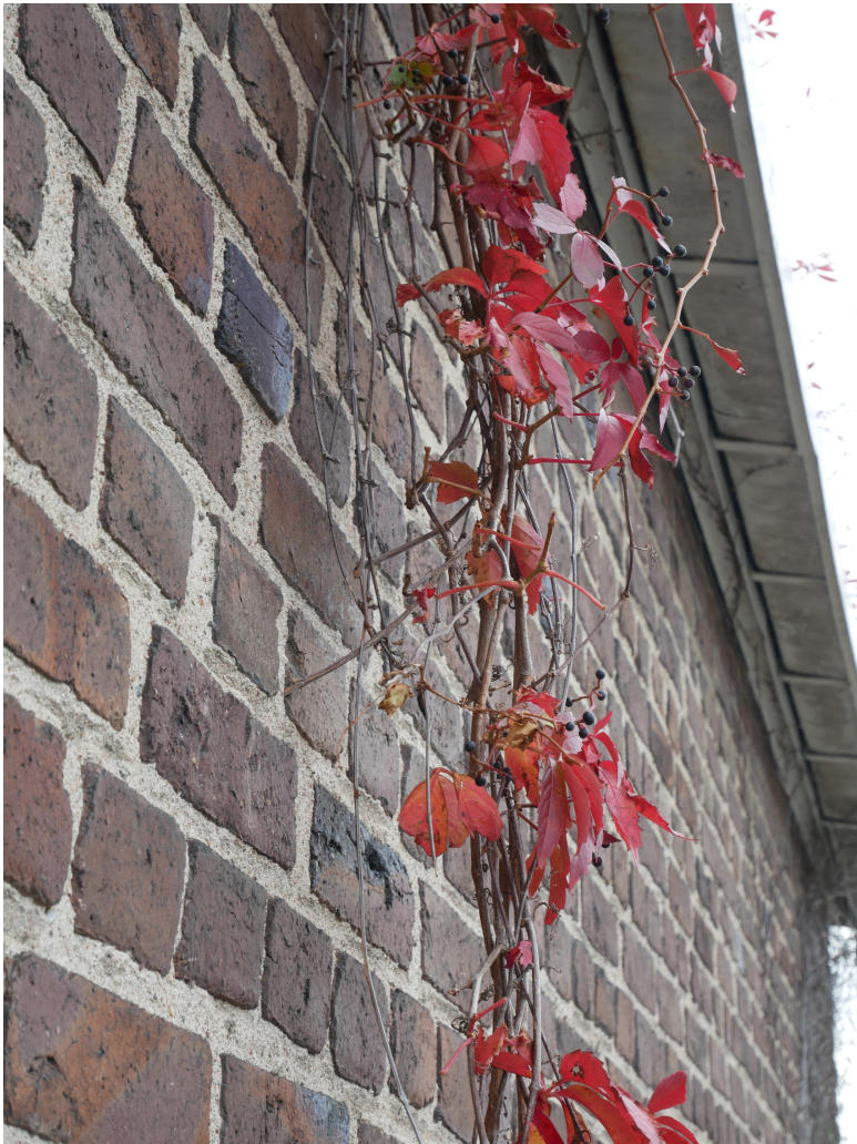
Tegelfasaden i kryssförband med vildvin. Rektangulär hängränna. 2019.
