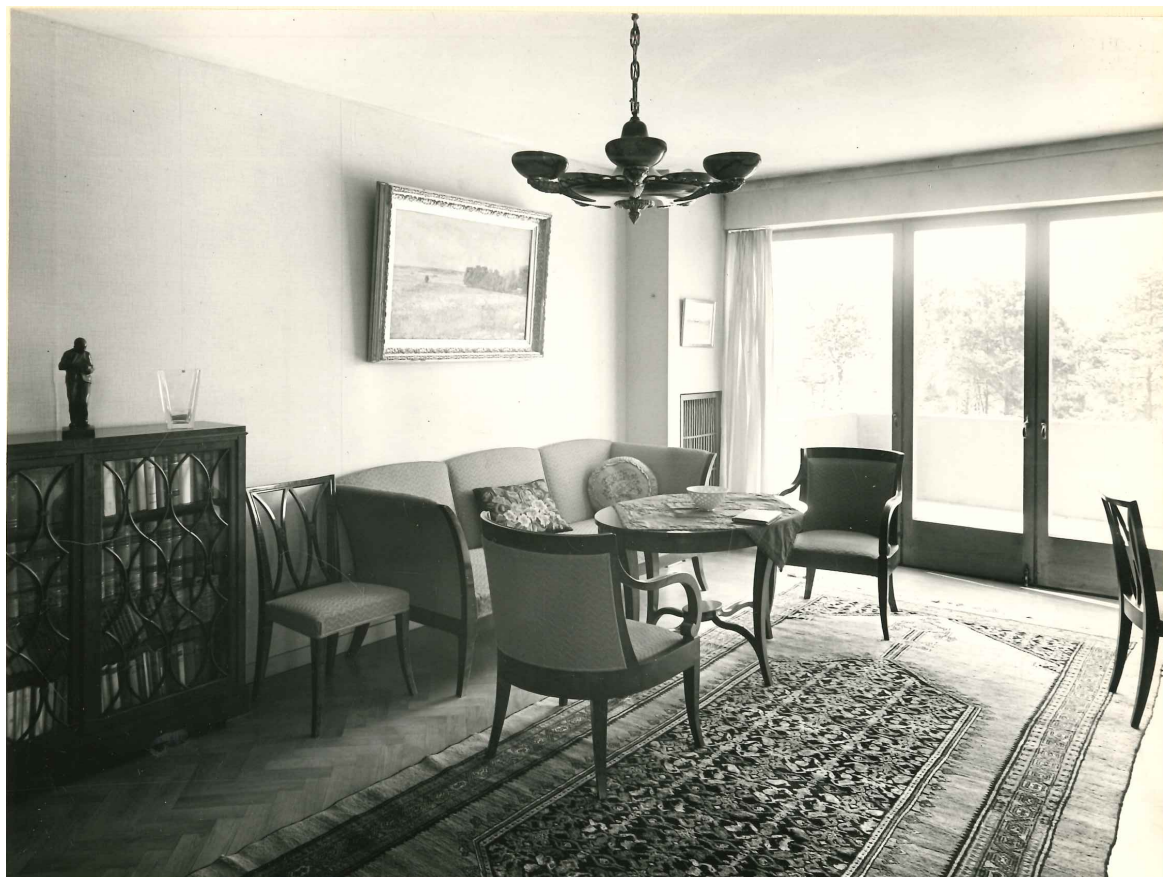
Foto 1952 dörrfönsterparti mot terrass med lägre bröstning på partiet än dagens parti.
