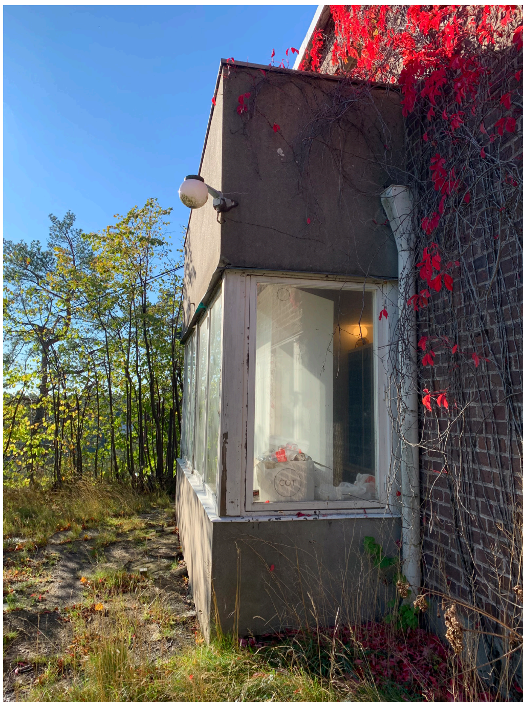
Fasadbelysning på burspråk. 2019.
