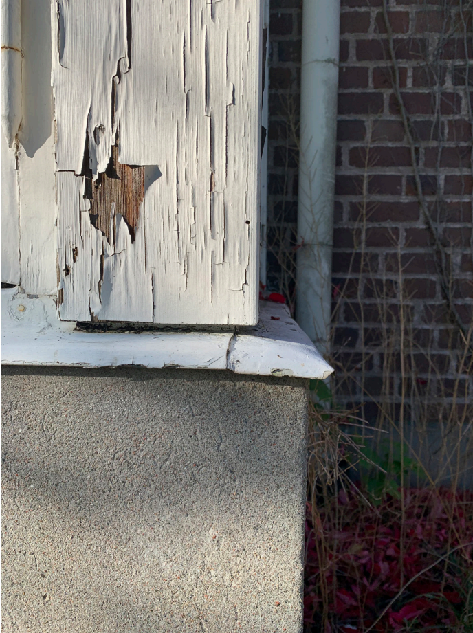
Plåtdetalj fönster och puts burspråk. 2019
