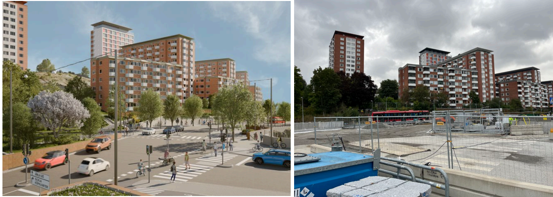
Bild 5: Visionsbilden (Tyréns, 2024) till vänster visar planerad utformning av etapp 1 efter färdigställd utbyggnad. Vy tagen från Sickla bro österut längs Värmdövägen med Alphyddan i bakgrunden och korsningen Värmdövägen/Sickla industriväg i förgrunden. Fotot (Nacka kommun, 2024) visar vy över Värmdövägen ner mot korsningen Alphyddvägen/Värmdövägen under pågående ombyggnad.
