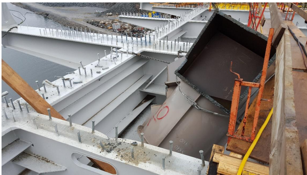
Bild 13. Den demonterade delen av tillfällig konstruktion som lyckligtvis landade i brolådan.
