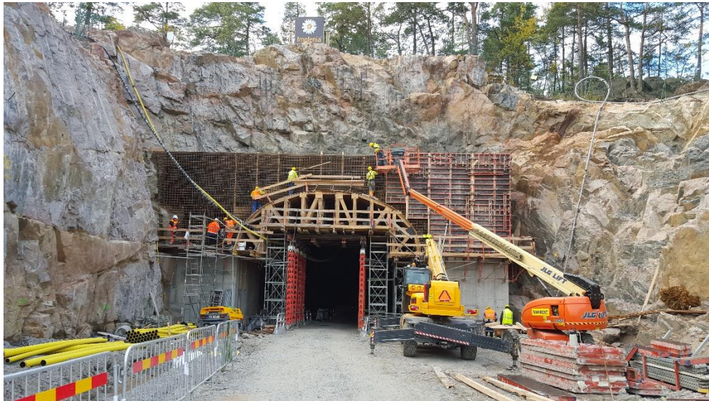
Bild 8. Förberedelser för sista gjutningen av portal för södra förskärningen som kläs med gabionmur.
