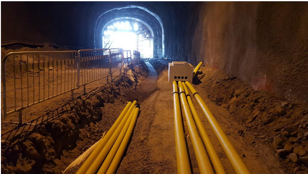
Bild 7. Markarbeten för elkanalisation i tunneln
