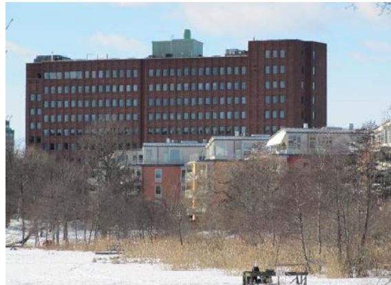
Fläktfabriken före detta huvudkontor: Den 12 våningar höga tegelbyggnaden färdigställdes 1959 som huvudkontor för Svenska Fläktfabriken. Arkitekt var Ture Wennerholm. Huset byggdes om till flerbostadshus 2004. Foto: Johan Asplund.
