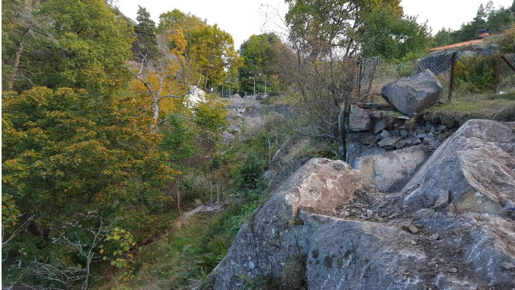
Bild 6. Vy mot Vikdalsvägen, bultarna i berget visar läget för träbrons pelare, det är brant och svårt.
