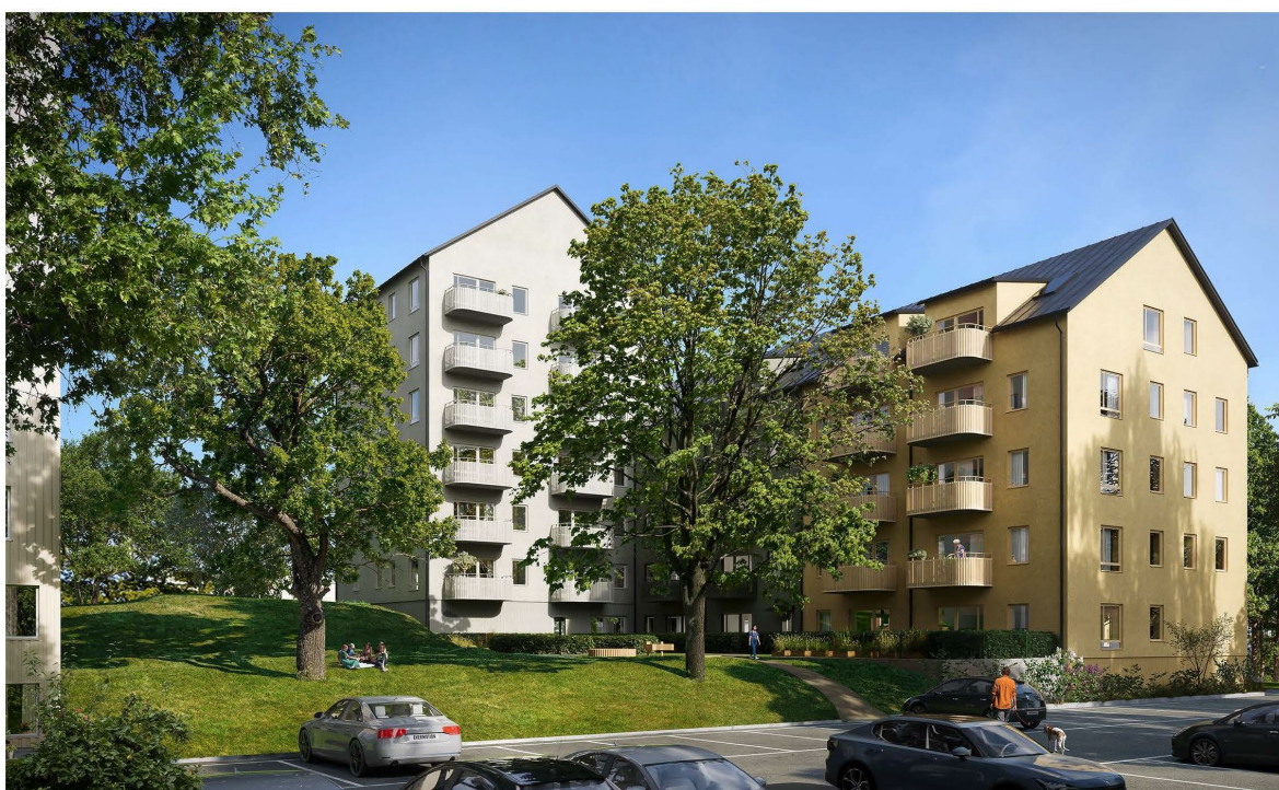
Figur 13: Möjlig utformning. Slutlig utformning avgörs i bygglovsskedet. Vy mot innergård. Bild av Larsson Arkitekter.
