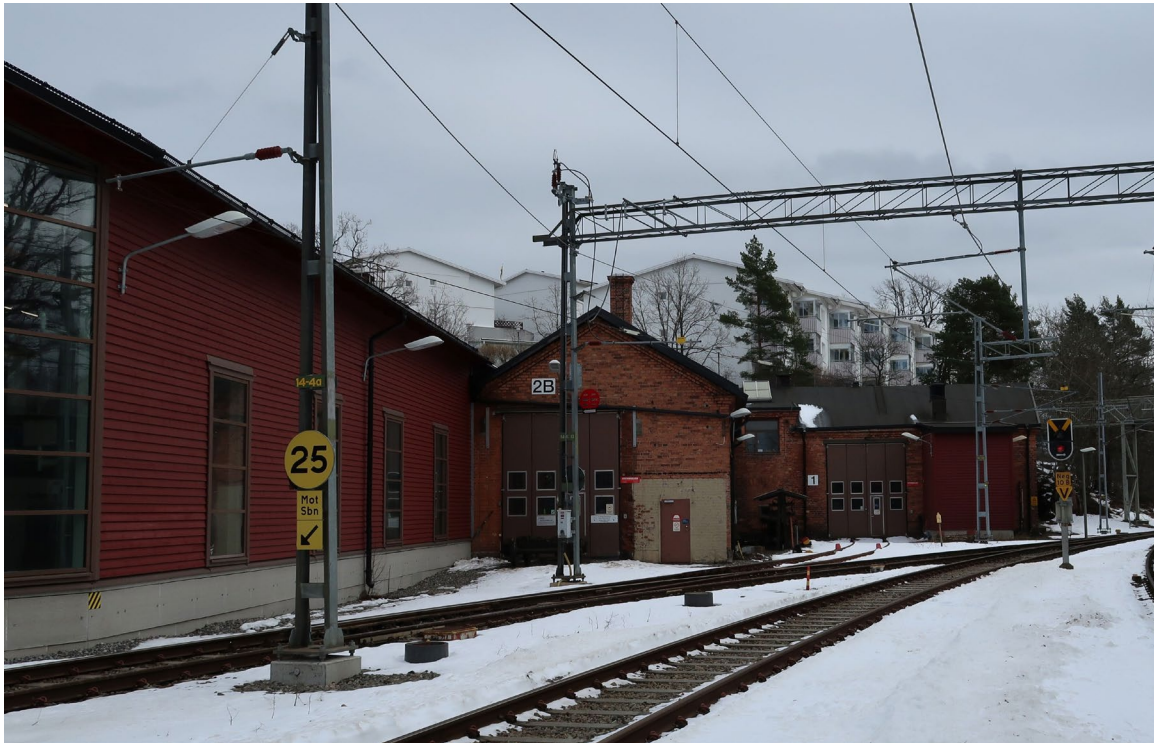
Figur 3: Tegel, liggande träpanel, fönster med vertikala former och takens former är viktiga karaktärsdrag hos den befintliga depåbyggnaden. Närmast i bild syns tillbyggnaden från 2017/2018. (Nacka kommun, 2023)
