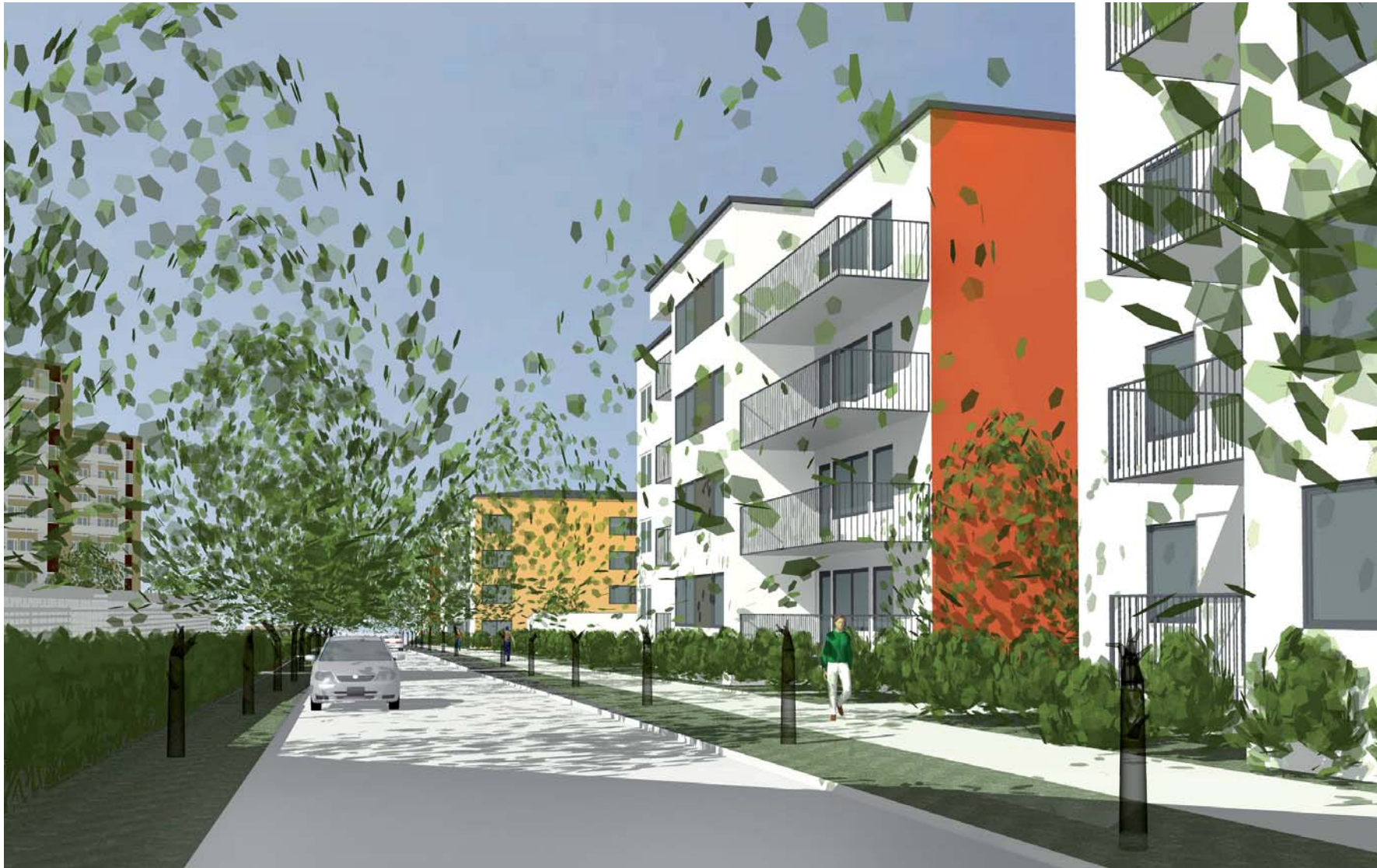
2. Stensövägen med den nya bebyggelsen till höger på nuvarande parkeringsyta; en ny trevlig gatumiljö med gröna förgårdsmarker och gatuträd, på väg ut till badet och Stensö udde.
