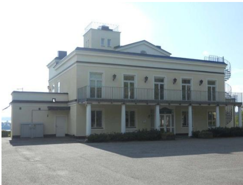
Huvudbyggnadens framsida och entré som också är byggnadens norrsida. (Byggnad nummer 5)
