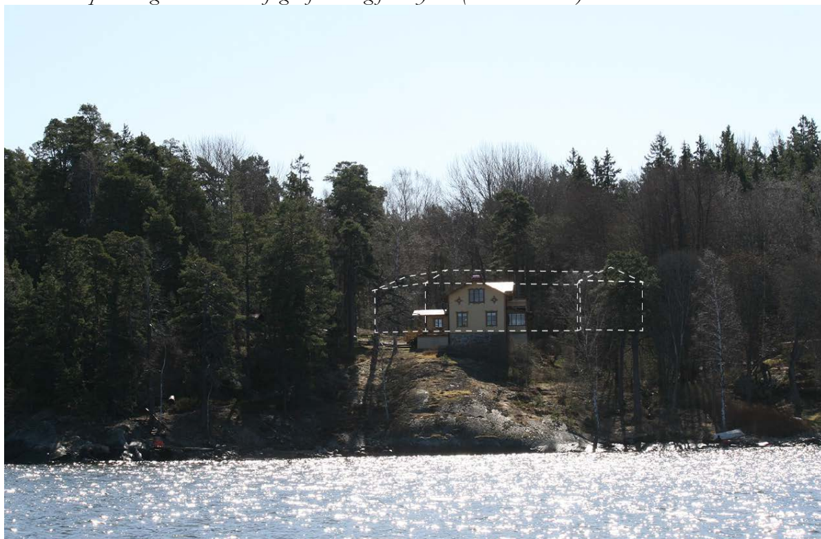
Vy från farleden som visar att byggnadsvolymen inte kommer att synas från farleden (arkitekter sr-k)
