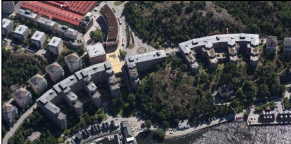
Flygfoto från norr, planområdet omfattar den högra av de tre storskaliga byggnaderna i branten.
