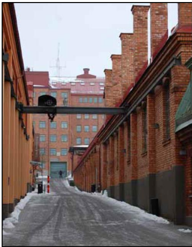
Delar av bevarad industribebyggelse.
