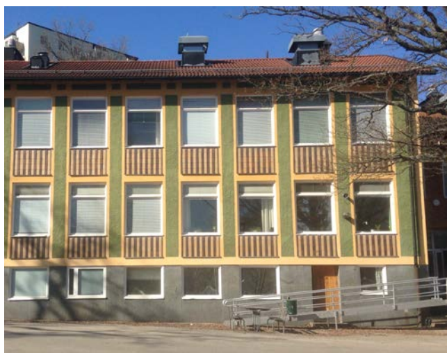
Befintlig skolbyggnad med tidstypiska material och horisontellt uppbyggd fasad
