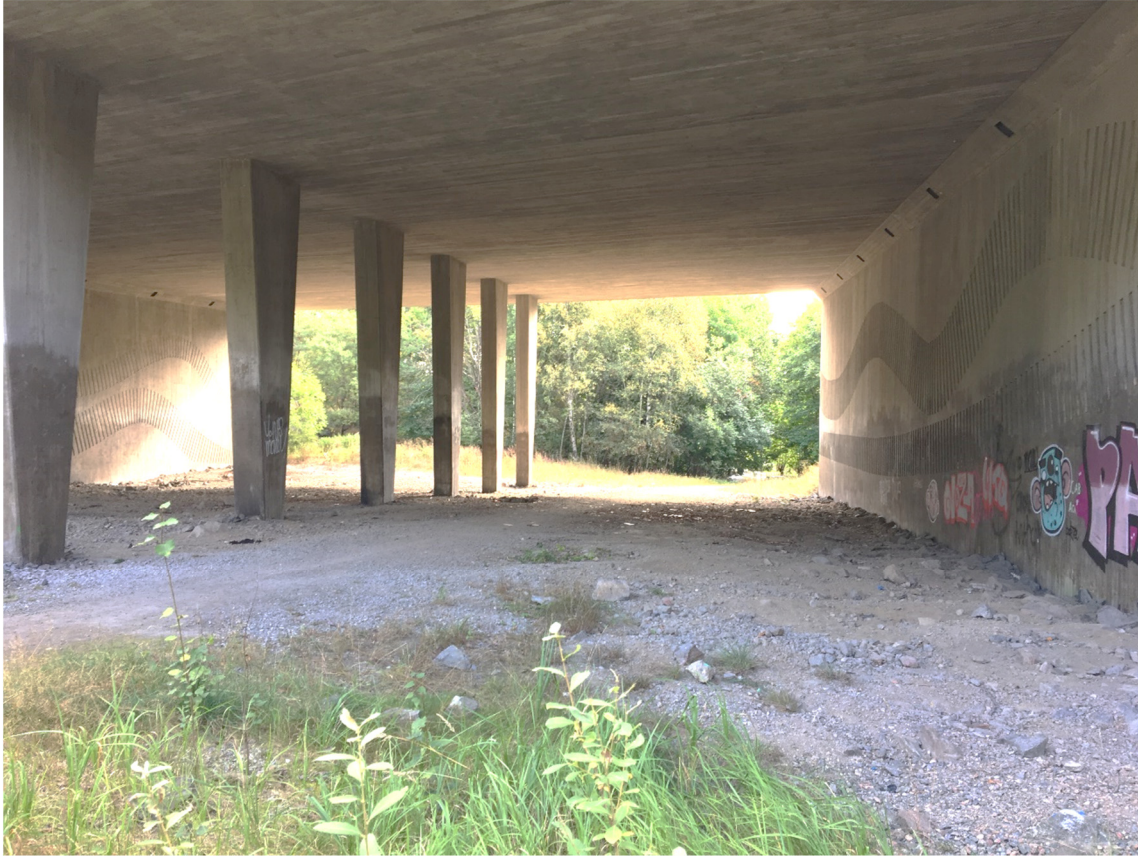
Vägporten i Birkavägens förlängning sedd från Ryssbergen.
