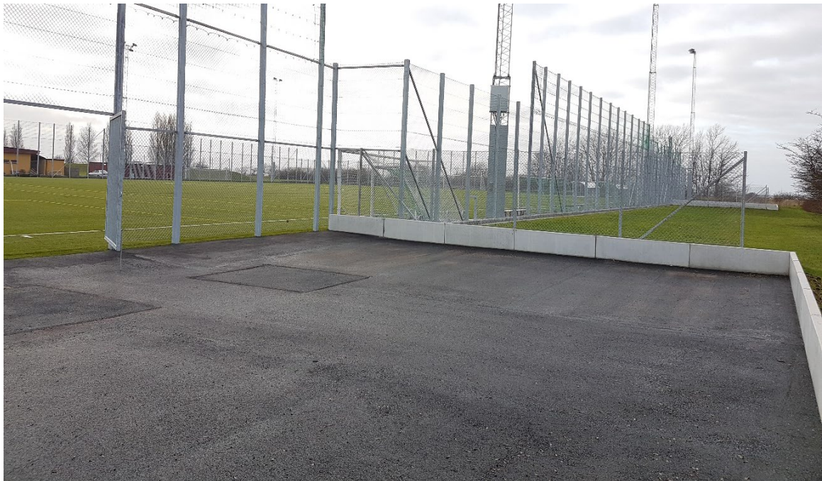
Figur 13. Exempel på asfalterad plats avsedd för snöupplag. Bunkeflo IP, Malmö.
