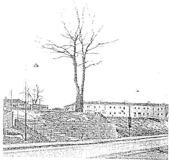
Eken med sin nya stödmur
