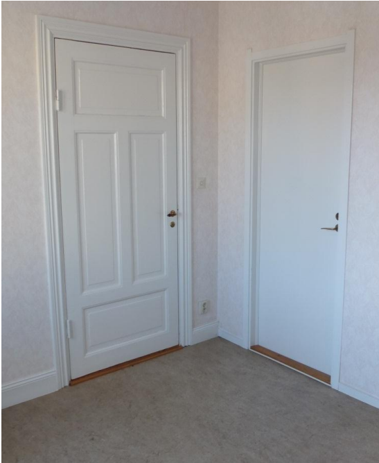
Övervåningen i Norra villan. Spegeldörrar med profilerade foder bör bevaras i största möjliga uträkning.
