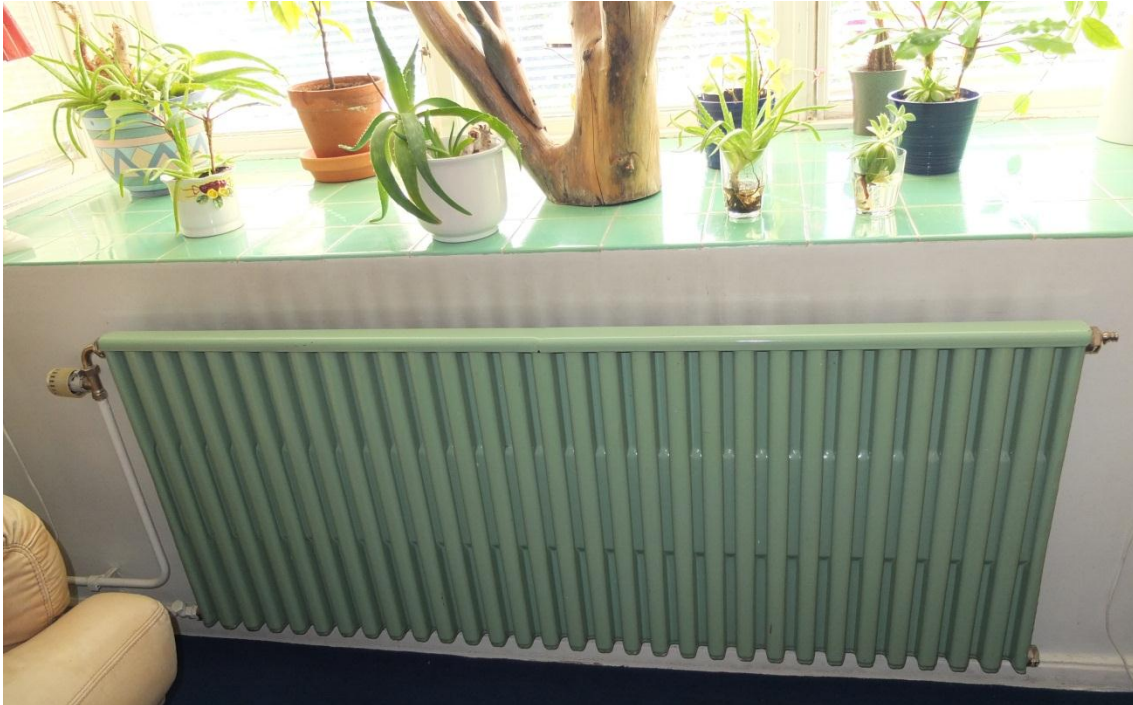
Burspråk och grön radiator i lägenhet.
