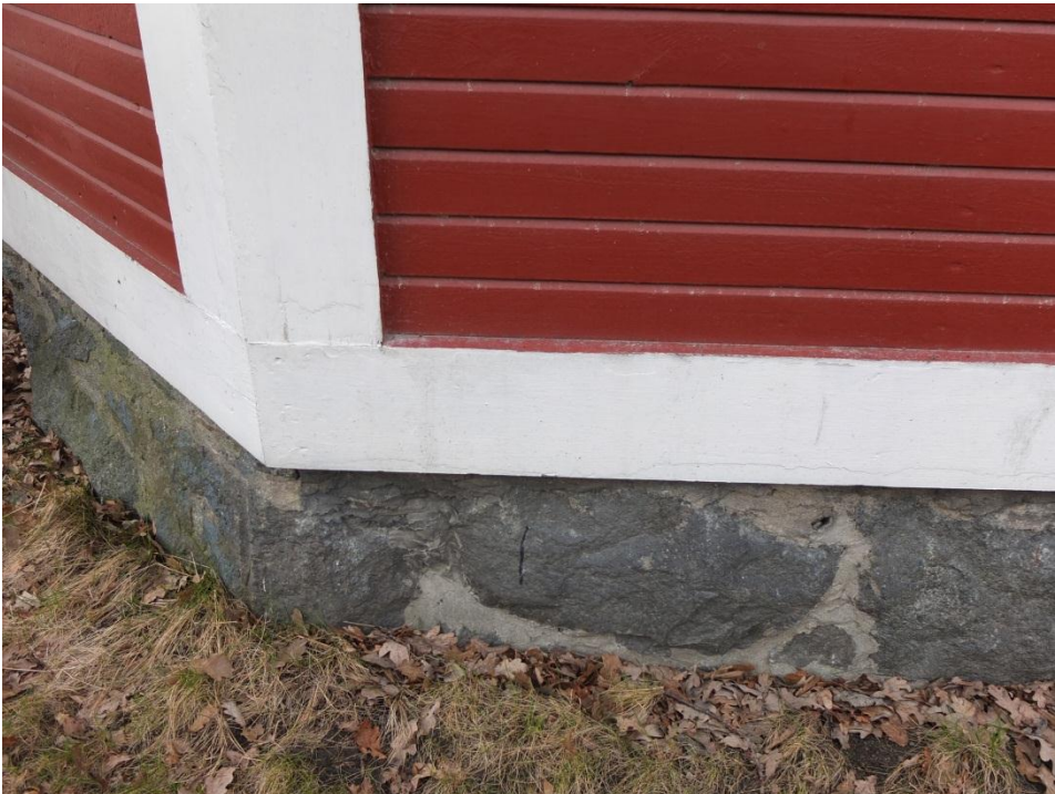
En fotbräda – utan plåt på delar av fasaden - markerar bottenbjälklaget och fasadens möte med den grova sockeln. En plåttäckning skulle ett klumpigare intryck.
