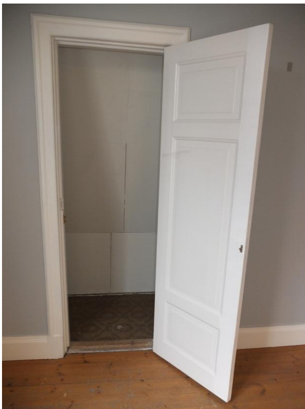
Exempel på spegeldörr som bör tas tillvara.
