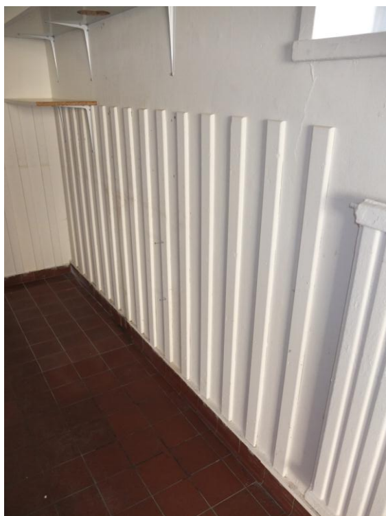
Träribbor som skydd för väggen.
