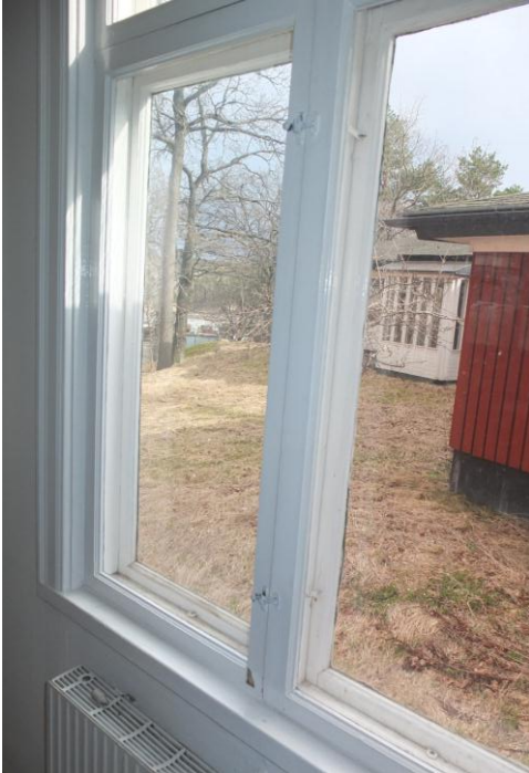
Södra villan har bevarade okopplade fönster.
