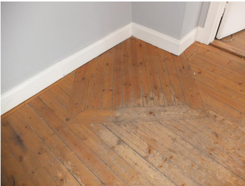
Brädgolv som visar den tidigare placeringen av en kakelugn.
