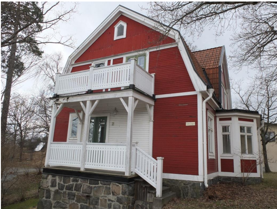
Norra villans östra fasad.
