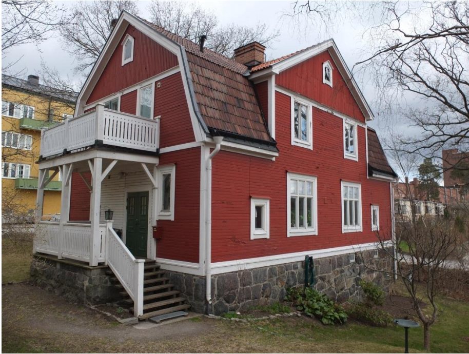
Norra villans västra och södra fasader.
