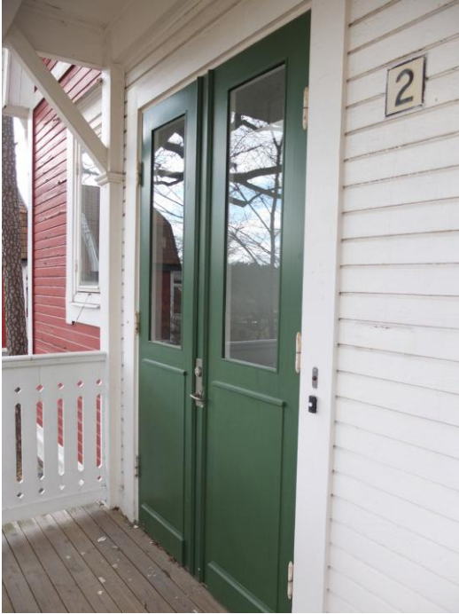
Entrédörr på östra verandan. Dörren är utbytt men stilmässigt anpassad.
