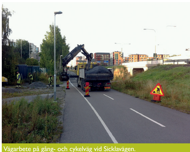
Vägarbete på gång- och cykelväg vid Sicklavägen.
