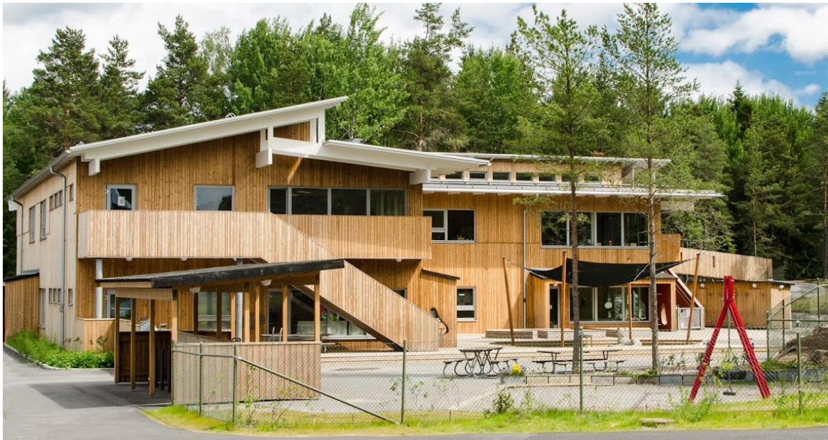
Källängsvägens passivhus förskola med solfångare på tak för extra energi vid behov
