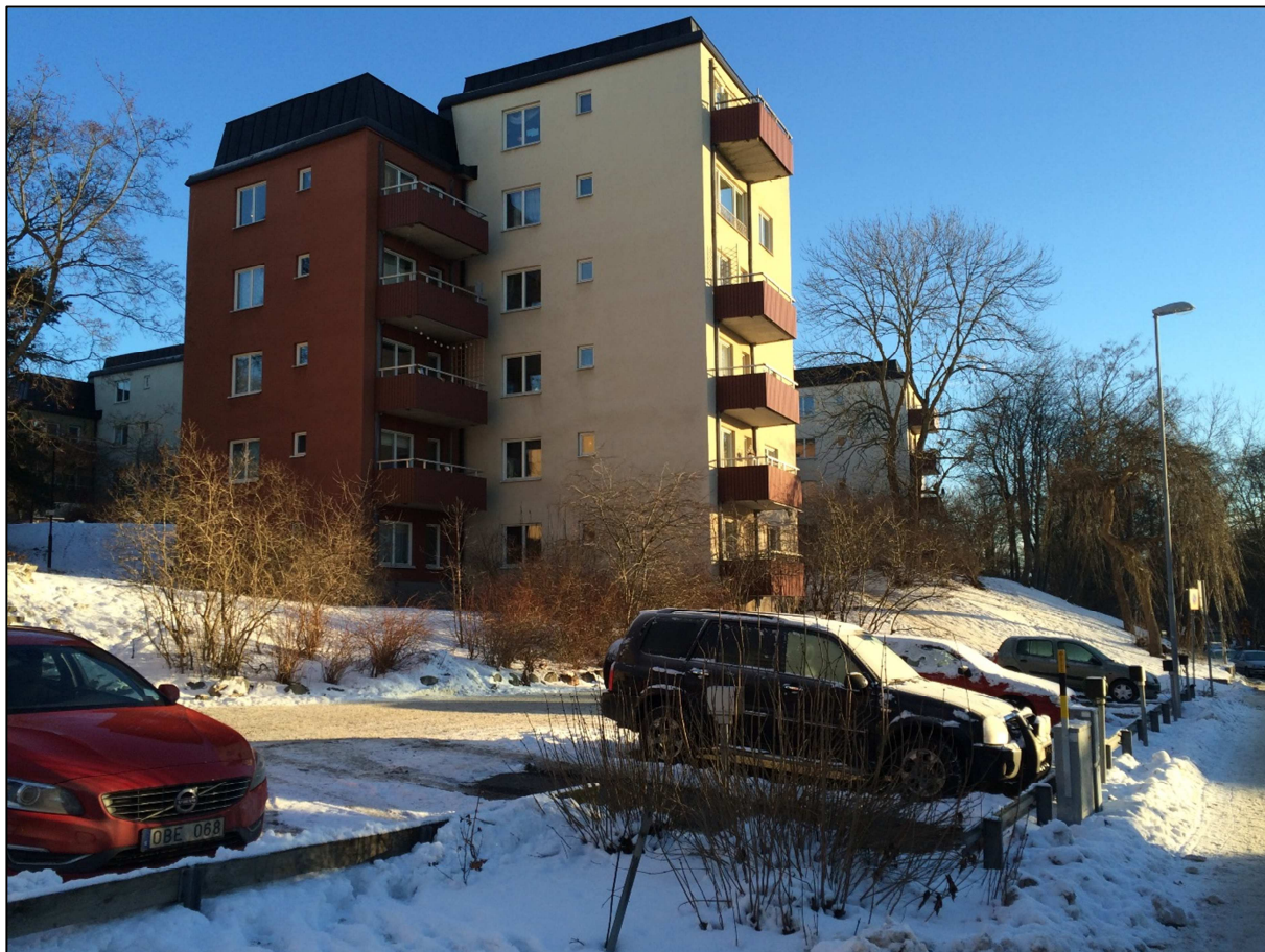
Figur 2-2. Fastighetens infartsväg med parkeringsplatser för bilar i sydväst och den branta slänten till höger i bilden.
