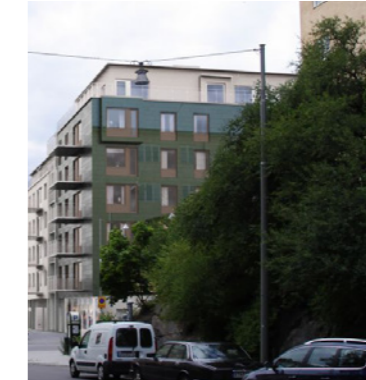
Referens grön plåtfasad KV tobaksmonopolet
