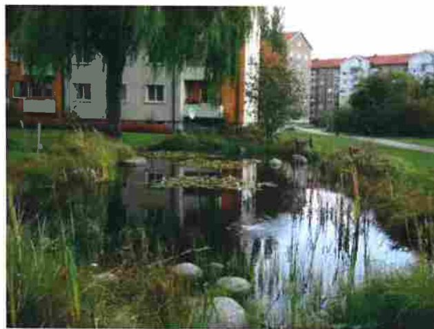
Dagvattenhantering med dagvattendamm, Sweco, dagvattengruppen
