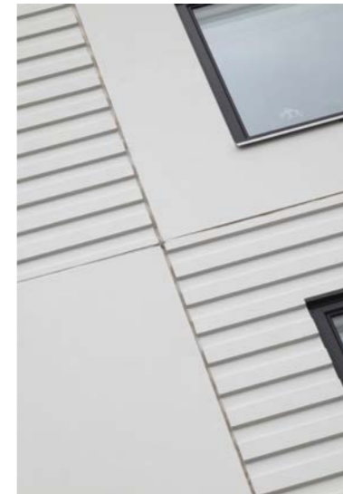
Betongelement med omhändertagna fogar
