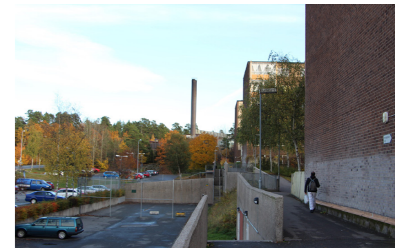
Trafikseparerade ytor i olika våningsplan, med gångbanor ovanpå garage.
