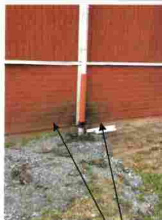
Stuprör läcker och förstör fasaden
