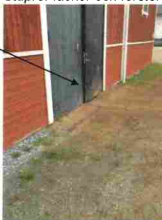
Stuprör läcker och förstör fasaden
