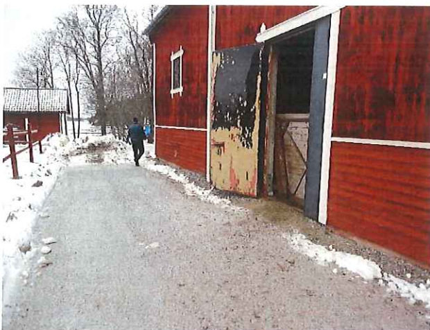
Bild 18, Port i västra fasaden (mot norr)
