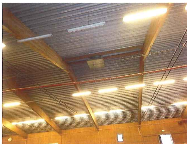
Bild 2, tak av profilerad plåt isolering + papp
