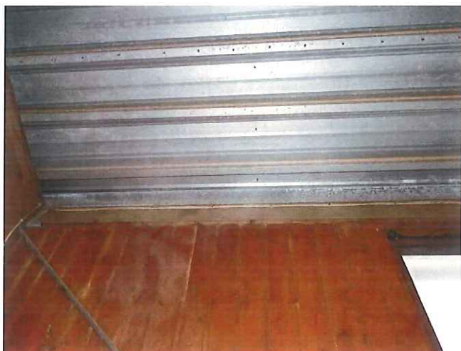
Bild 9, yttervägg i läktarnivå
