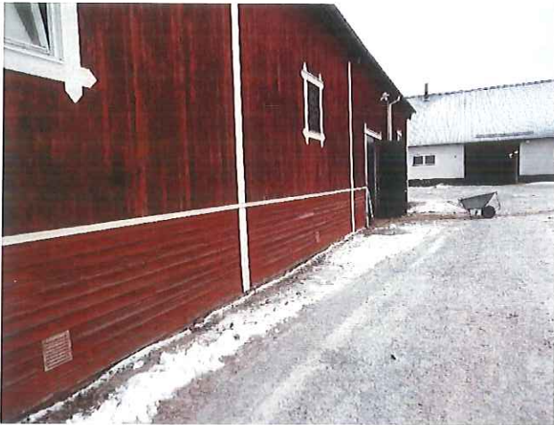
Bild 16, Västra fasaden (mot söder)
