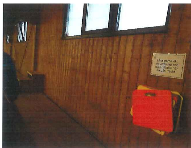
Bild 10, yttervägg i läktarnivå
