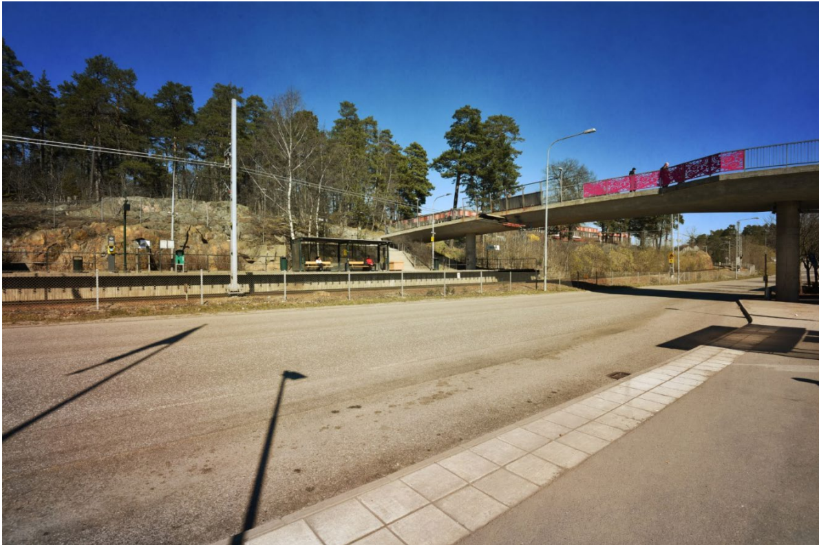
Gångbron förbinder Fisksätra centrum med stationen och naturområdet. Fisksätravägen och spårområdet utgör barriärer. Vy från söder. Foto av Sweco.
