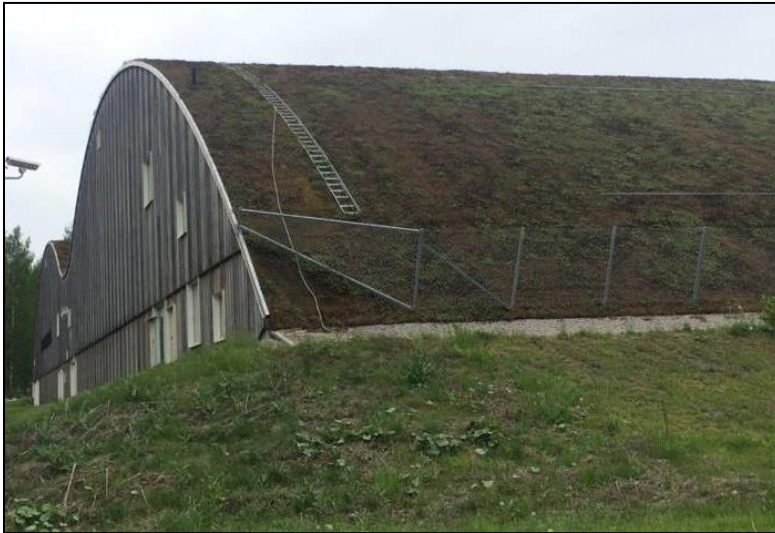
Figur 4. Grönt sedumtak på SEB USIF arena, Uppsala. Foto: Erika Hagström, Structor Uppsala AB (2016).
