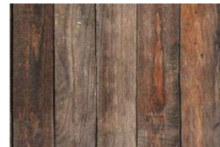
Inslag av mörkare trä vid balkong och entré
