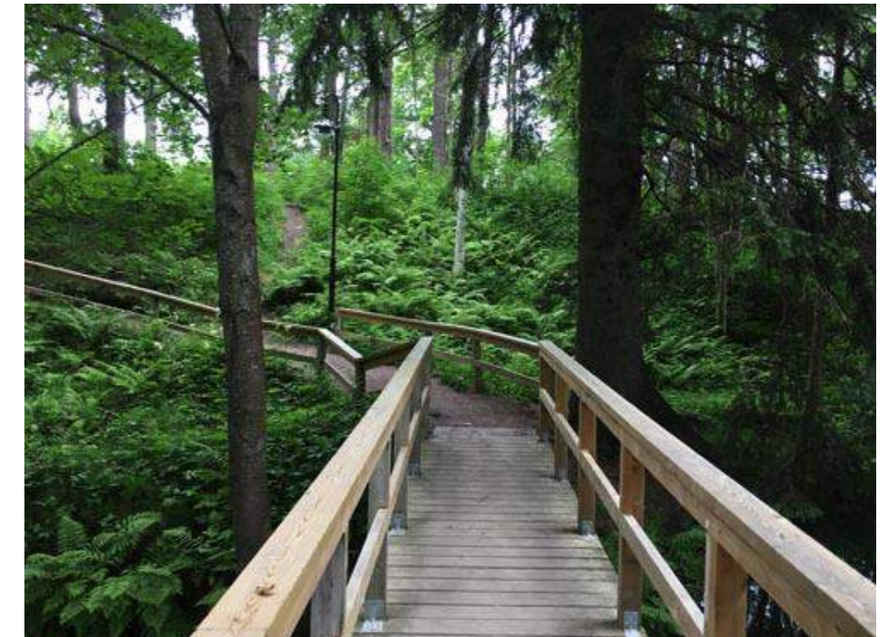
Träkonstruktion för att ta upp höjdskillnad
