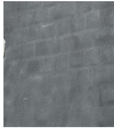
Puts gråskala med detaljering i näraliggande kulörer
