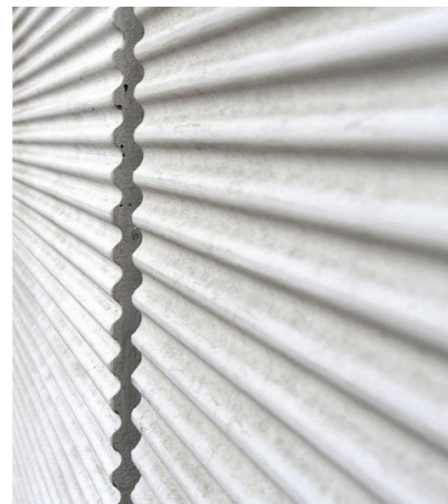
Betong i sockelväning med olika mönsterverkan och kulör
