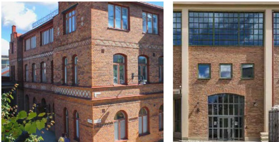
Industribyggnad från det förra sekelskiftet i Järla sjö: Turbinhallen tillhörande Alfa Lavals ångturbinfabrik. Foto: Semrén & Månsson
