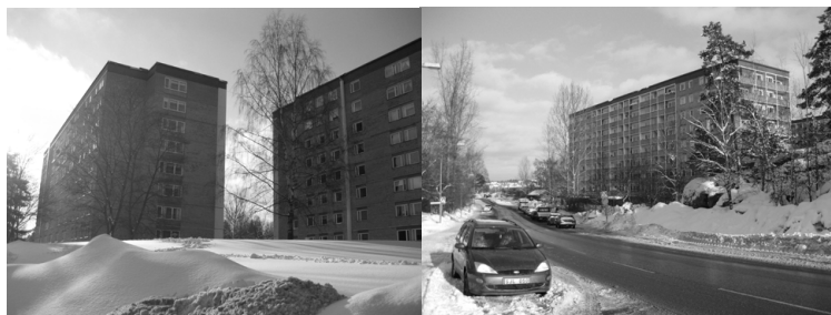
lamellhus längs Oxelvägen
