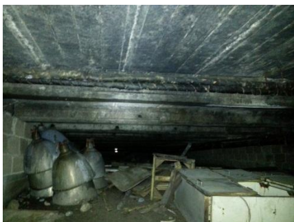
Foto 7 - Krypgrund för omklädningsbyggnad.
