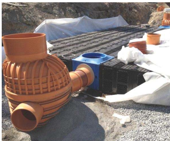
Exempel på dagvattenkassetter i Stockholm (bildkälla Sweco).
