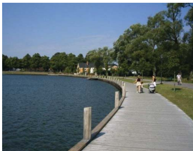
Exempel på strandpromenad med dagvattenrening i Växjö. Sedimenteringen sker under bryggan genom att orenat vatten skiljs från renat vatten med hjälp av en avskärmande duk under vattentam (bildkälla: Sweco).
