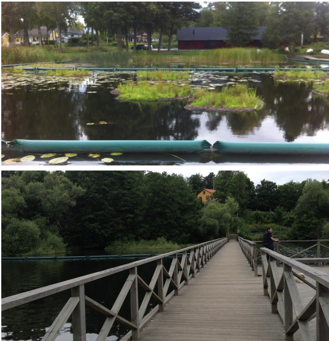
Figur 15. Översta bilden är en skärmbassäng i Täby kommun anlagd med flytande växtbäddar och den nedre bilden är en skärmbassäng i Trekanten, Liljeholmen utan flytande växtbäddar.
