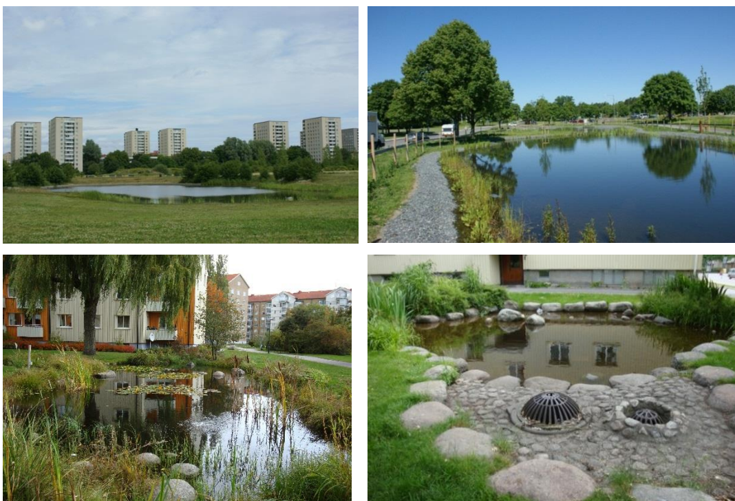
Figur 11. Exempel på dagvattendammar med naturlig utformning i bostadsnära bebyggelse.
