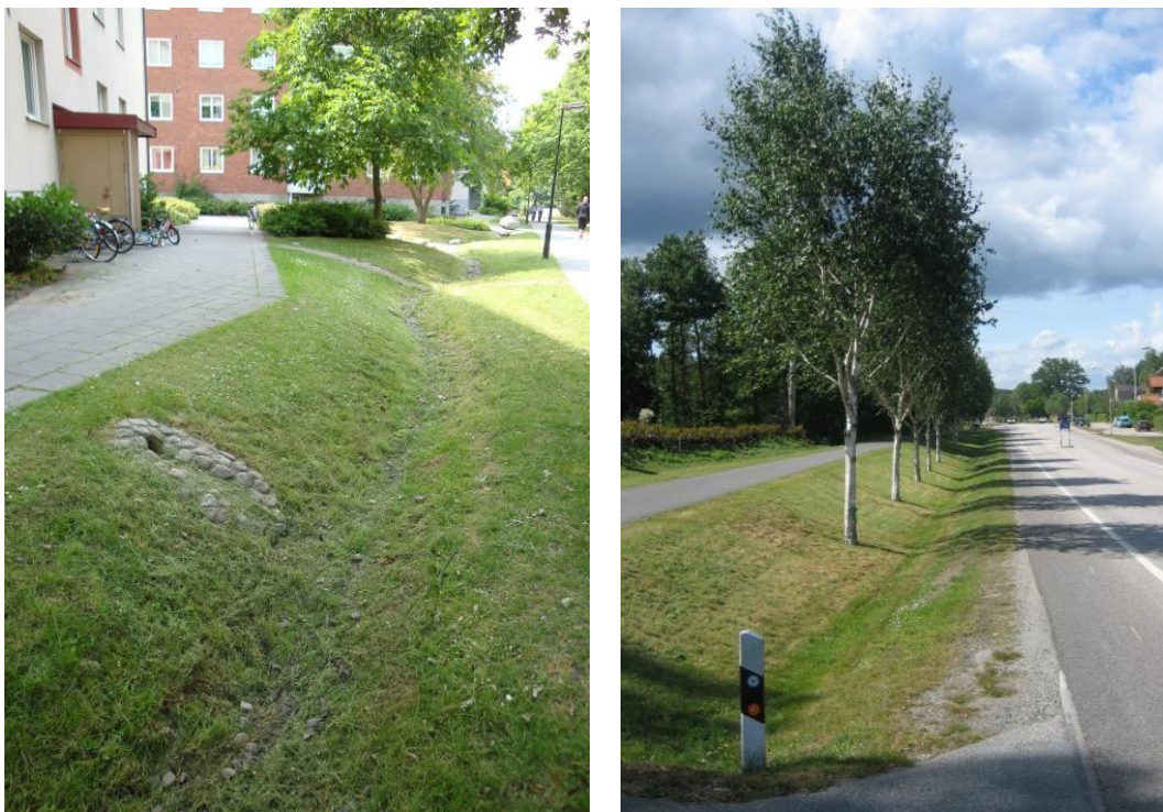
Figur 14. Exempel på utformning av svackdiken utan kantsten längs gata och i bostadsområden.
