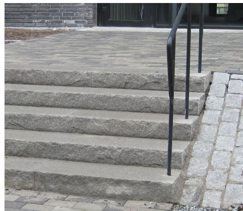
Granit i trappor och murar ska påminna om områdets befintliga berggrund.
