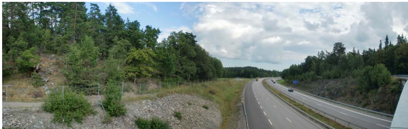
Vy över Värmdöleden (väg 222) med programområdet i fonden
