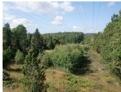
Befintlig kraftledning i västra Kil
