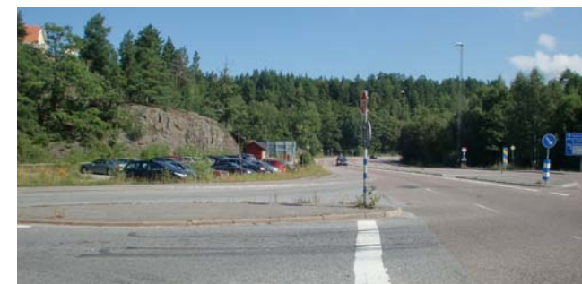
Korsningen Värmdövägen-Gamla Skärgårdsvägen byggs om till cirkulationsplats
