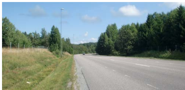
Bred vägbana på Gamla Skärgårdsvägen (väg 622)
