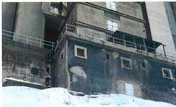
Befintligt metallräcke på sockelns krön.
