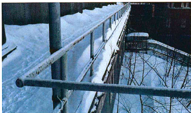
Befintligt metallräcke, detalj.
