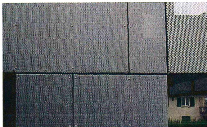
Exempel på fasadmaterial av metall; perforerade aluminiumkassetter.
