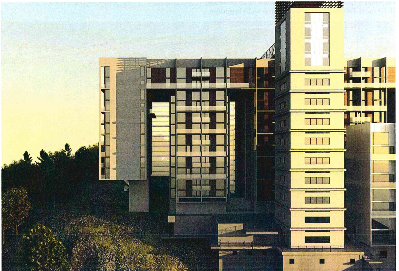
Östra delen av hus 19 sett från norr.
