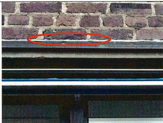
Bild 22. Risk för att det finns PCB i fog.
