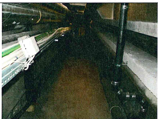
Bild 20. Avloppsrör med ringar i skarvarna samt avloppsrör med MA-kopplingar.
