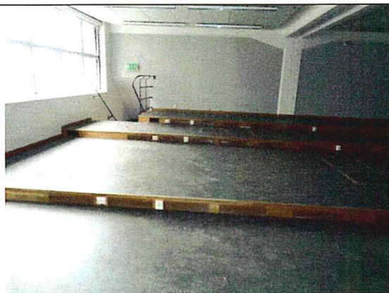
Bild 24. Uppstolpade golv i en del andra lokaler. Ytan under golvet är inte tillgängligt som i föreläsningssalen.
