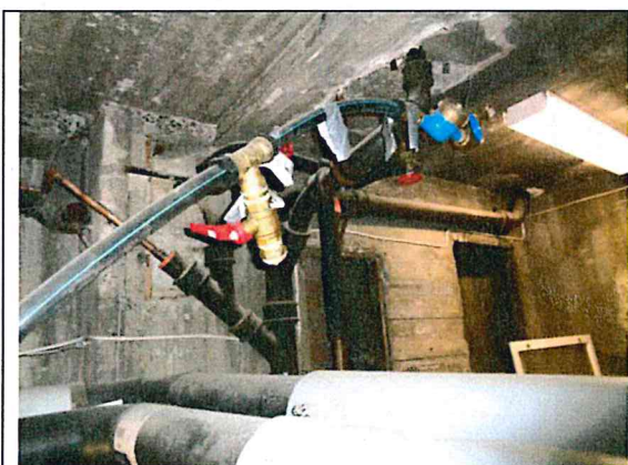
Bild 19. Avloppsrördelvis med blydiktade skarvar.
