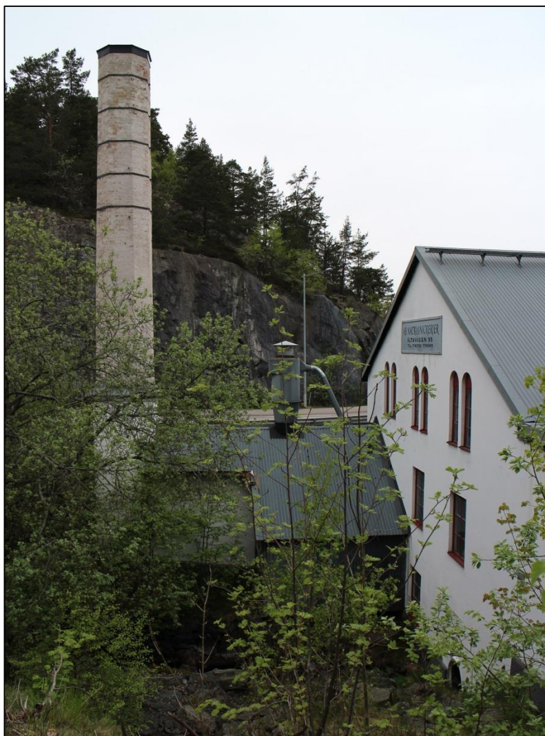
Bild 13. Den före detta kvarnbyggnaden från 1870-talet som idag rymmer snickeri, har ett tidstypiskt utförande av fasader och fönster (Nacka, 2011).
