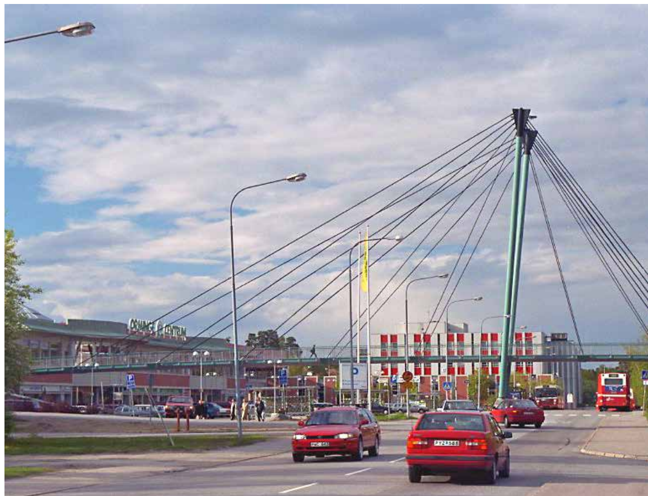
Orminge centrum, Kanholmsvägen. Centrumhuset till vänster i bilden och Ormingehuset bakom bron.
