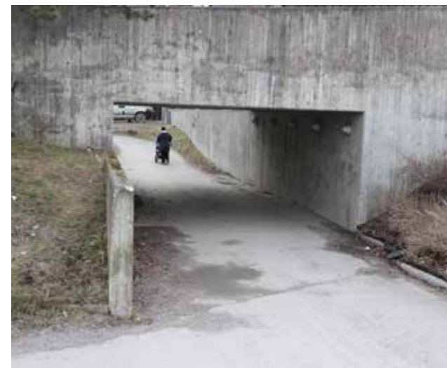
Gång- och cykeltunnel vid panncentralen
