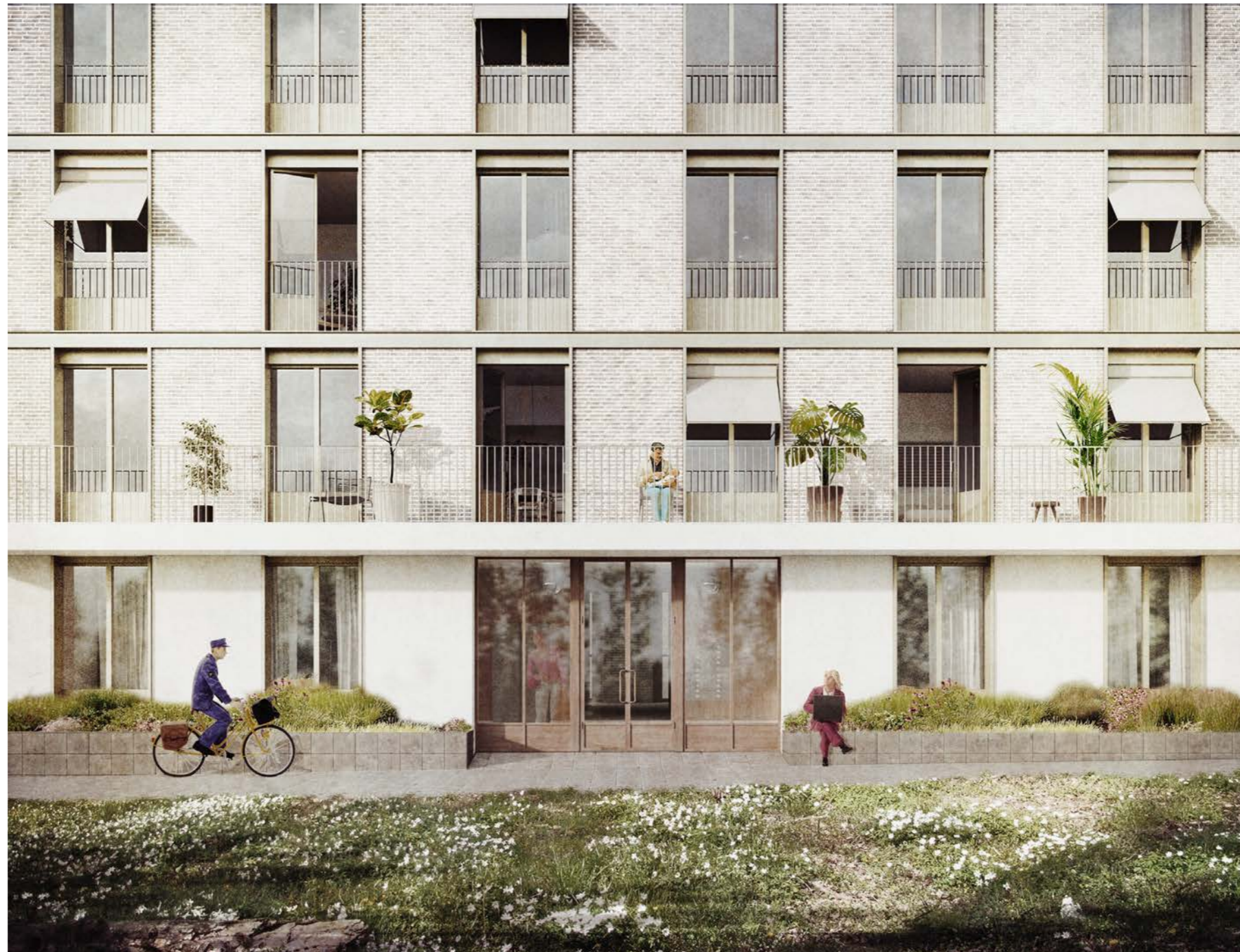
Barriärhusens entréer mot det kuperade landskapet
