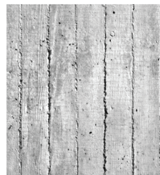
Betong gjuten mot trämatris.
