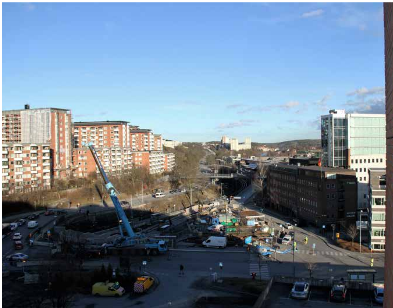
Blivande knutpunkt i Sickla, med Saltsjöbanan, Tvärbanan och Tunnelbanan.
