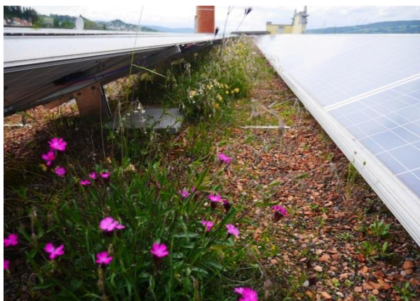
Grönt tak i kombination med solceller.
