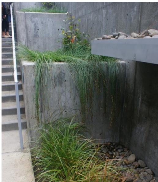
Avvatning av terrasserade innergårdar med hjälp av planteringar, rännor och överfall.
