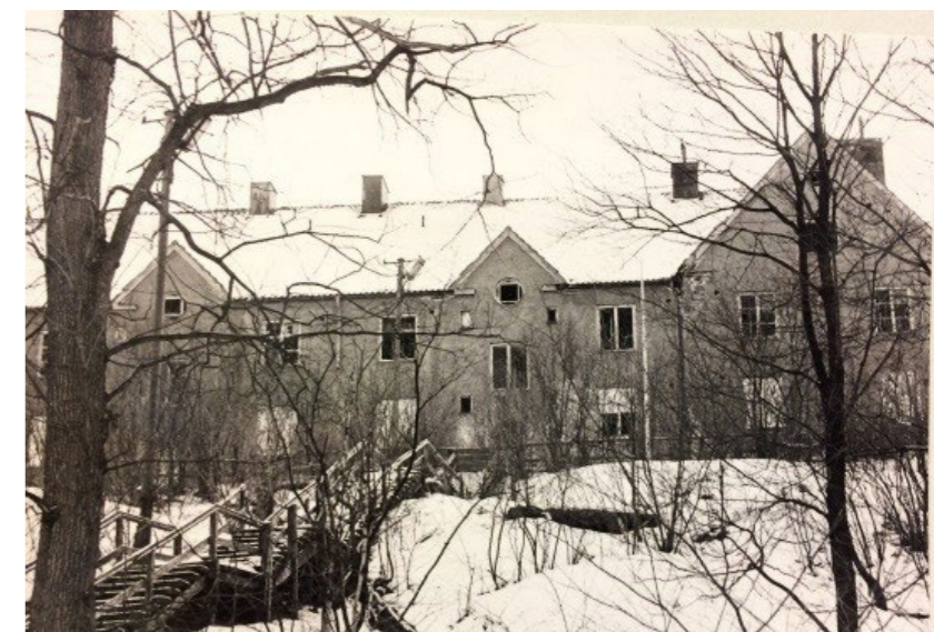
tidigare bostadsbyggnad, nu riven
