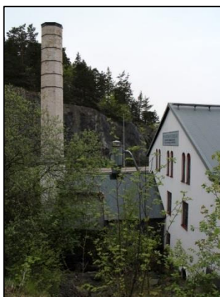
Bild 11. Den före detta kvarnbyggnaden från 1870-talet som idag rymmer snickeri, har ett tidstypiskt utförande av fasader och fönster (Nacka, 2011).
